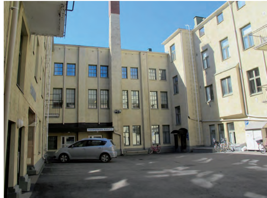
Juhalsaliiven / Tampereen pantin tilat sijaitsevat pihan länsisiiven rakennuksessa.
