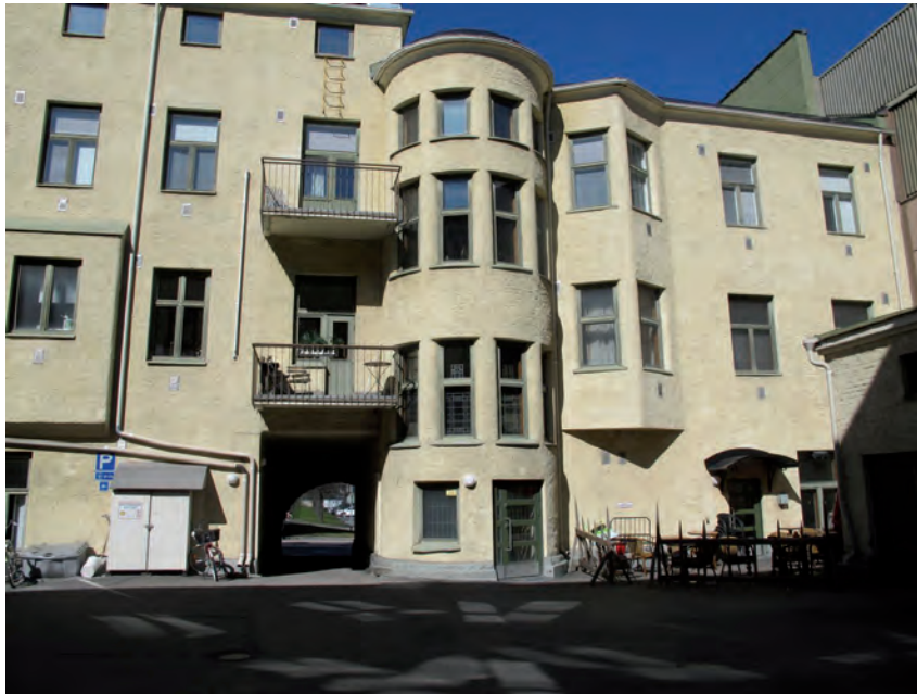
Ravintolan/päärakennuksen takajulkisivu, jossa on pyöreä porrashuone ravintolakerrokseen.
